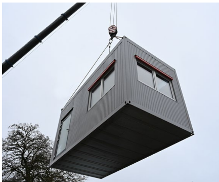
Abbildung 18: Anlieferung eines Moduls
