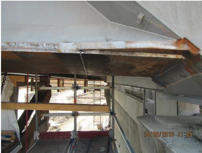
**Bild 8** Verstärkung Untergurt, erste Lage, im Untergurtbereich
