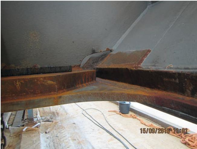
**Bild 10** Neuer Anschluss Querträger an Hauptträger
