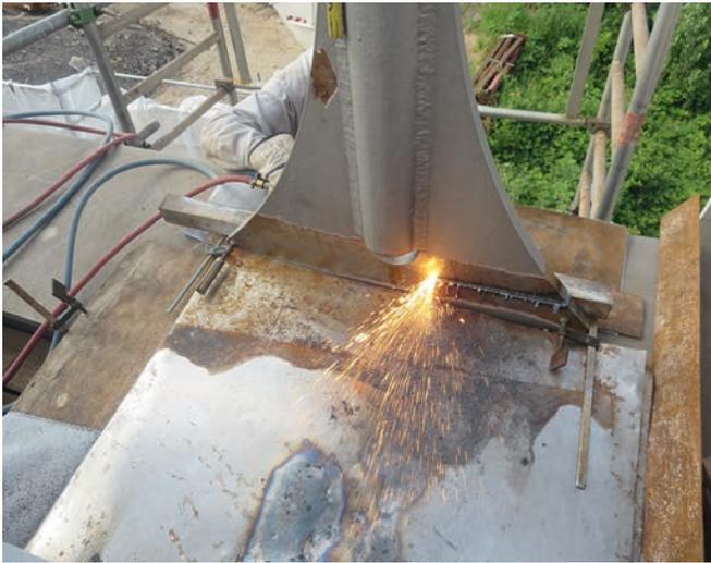
**Bild 13** Brennschnitt an den unteren Hängeranschlussblechen
