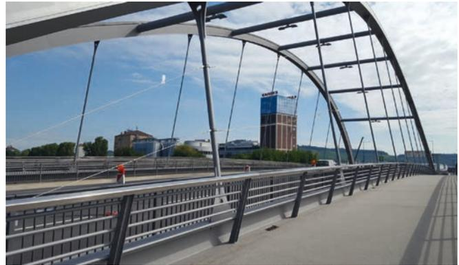
**Bild 14** Seilverspannung der Stabbogenhänger
