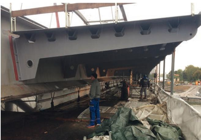
**Bild 12** An die Hauptträger neu montierte Rad- und Gehwegkonstruktion
