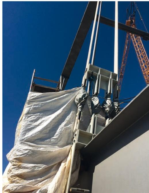
**Bild 5** Hilfskonstruktion am Bauwerk, eingebaut während des Hängertauschvorgangs
